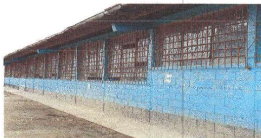
Foto 6: Sustitución de balcones de metal
