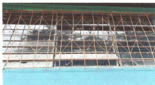
Foto 5: Sustitución de balcones de metal
